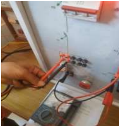
Gambar 3 Pengujian pengukuran tegangan
