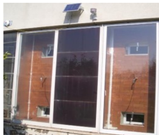
Gambar 2. Aplikasi pemasangan PV-Trombe Wall
