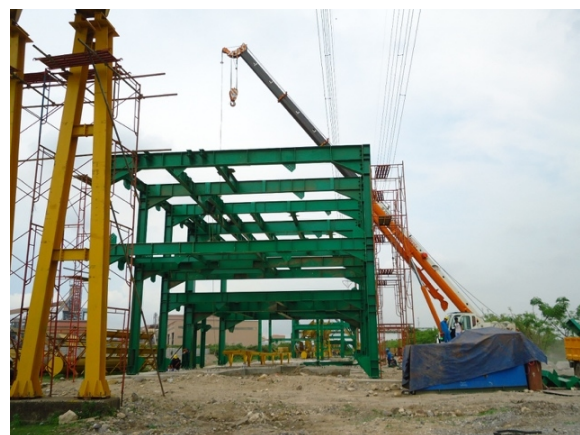
Gambar 7. Pemasangan konstruksi baja
