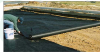
Gambar 12. Pemasangan geotextile untuk mencegah bercampurnya butiran halus tanah dengan lapisan beton di atasnya
