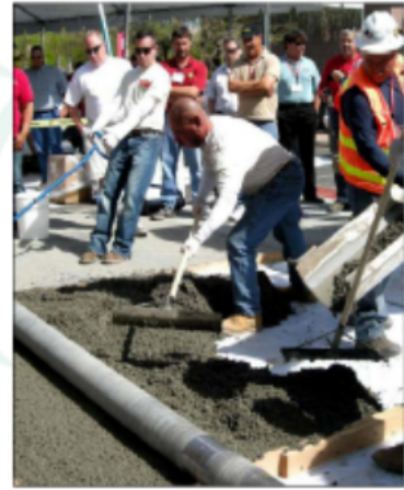
Gambar 16. Penghamparan campuran beton porous
