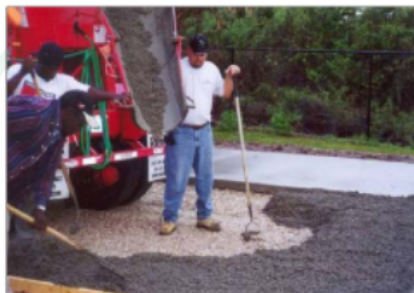
Gambar 15. Penuangan campuran
