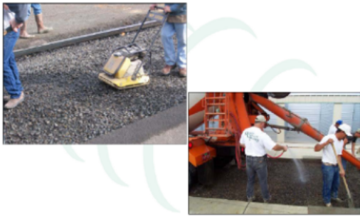
Gambar 13. Penyiapan lapis pondasi atas (pemadatan dan memberi kelembaban yang cukup pada base)
