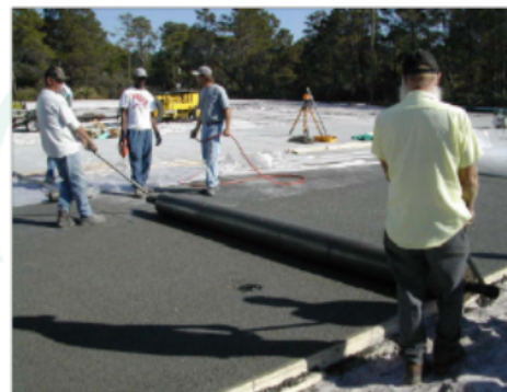
Gambar 18. Perataan permukaan beton dengan alat static roller
