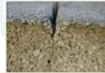
Gambar 22. Pembuatan celah sambungan
