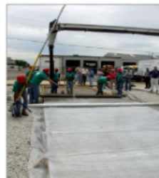
Gambar 24. Proses perawatan beton
