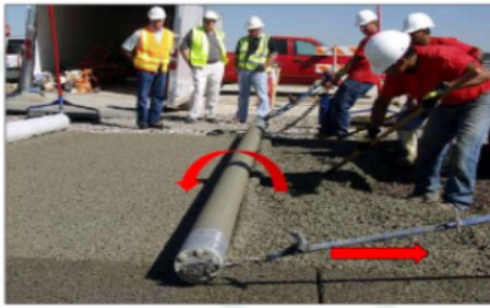
Gambar 19. Alat pemadat dan perata tanpa membutuhkan acuan/bekisting
