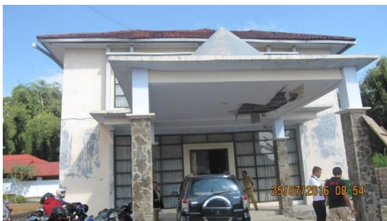
Gambar 1. Tampak depan Gedung KPPTSP
