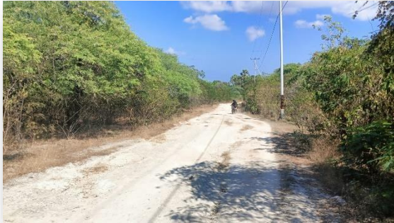
Gambar 10. Akses Jalan Jalur Atas Pulau Semau
